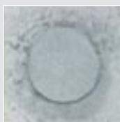
9 Mortelvulling, met opgelegd rozet (ook als afscherming van slecht uitgevoerde of beschadigde sparing)
