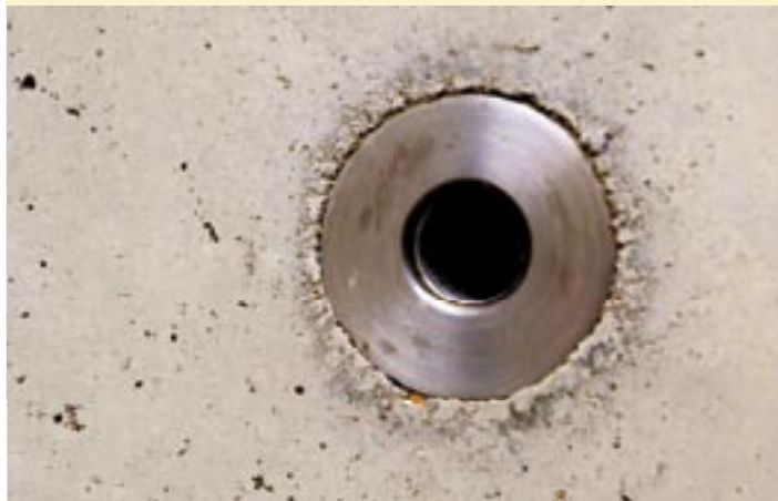
• RVS conus met inwendige schroefdraad
