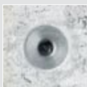
2 RVS conus ingestort, met inwendige schroefdraad (bruikbaar als bevestigingspunt)
